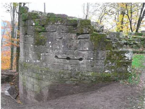
Fig. 13 et 14 Château de Nouveau-Windstein - Le bastion circulaire avant et après le sondage (Photo Alain Kieber)
