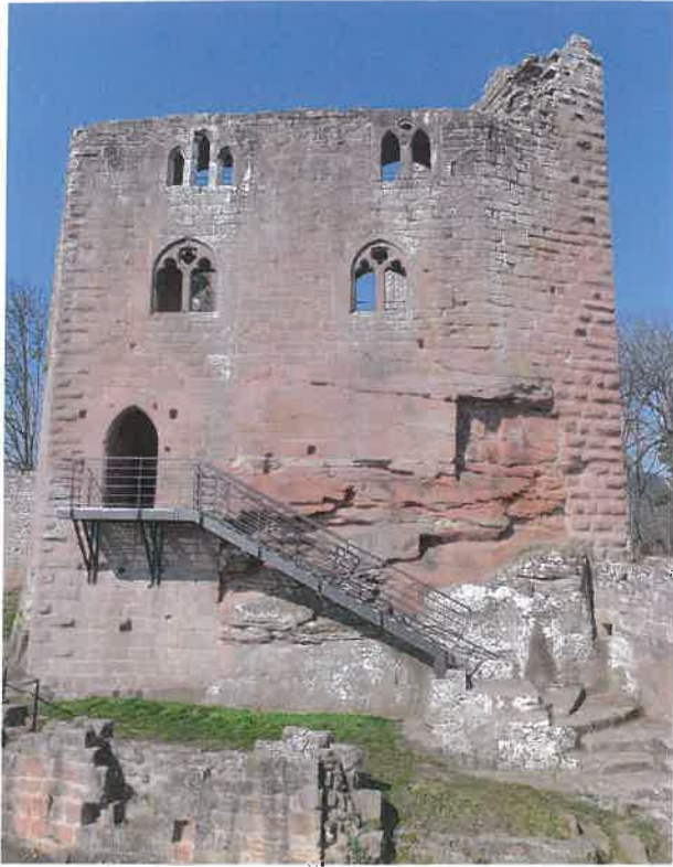
Fig. 17 Château de Nouveau-Windstein - Nouvel accès au logis (Photo Alain Kieber)
