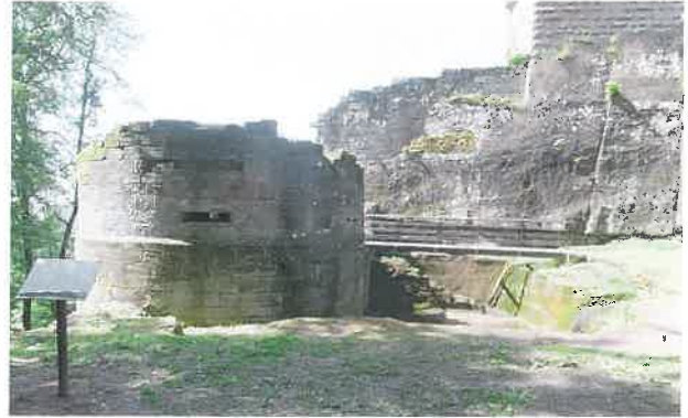
Fig. 19 Château de Nouveau-Windstein - La passerelle de la barbacane et le panneau d'information (Photo Alain Kieber)
