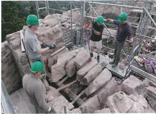
Fig. 15A Château de Kagenfels - La niche d'archère est du logis en cours de démontage (Photo Mathias Heissler)
