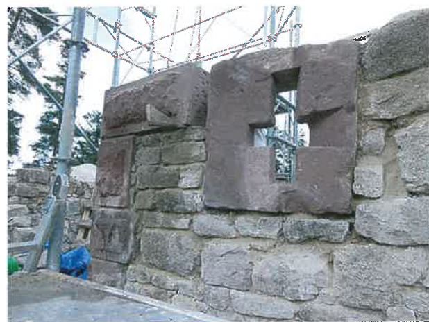
Fig. 16 Château de Kagenfels - Meurtrière MA en cours de remontage (Photo Mathias Heissler)
