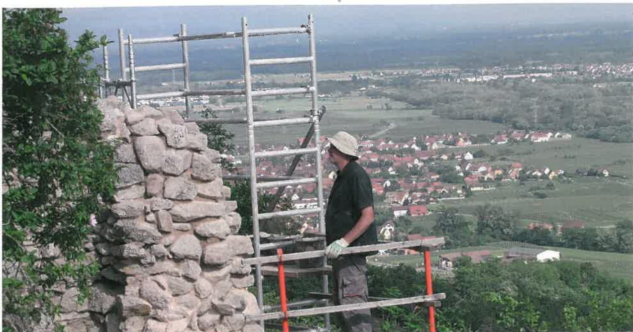
Fig. 30 Ramstein - Travaux de consolidation sur la tourelle sud (Photo Rémy Frey)
