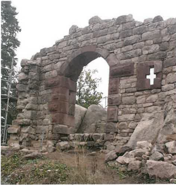
Fig. 26 Kagenfels - Porte PA après remontage, vue de l'extérieur (Photo Mathias Heissler)
